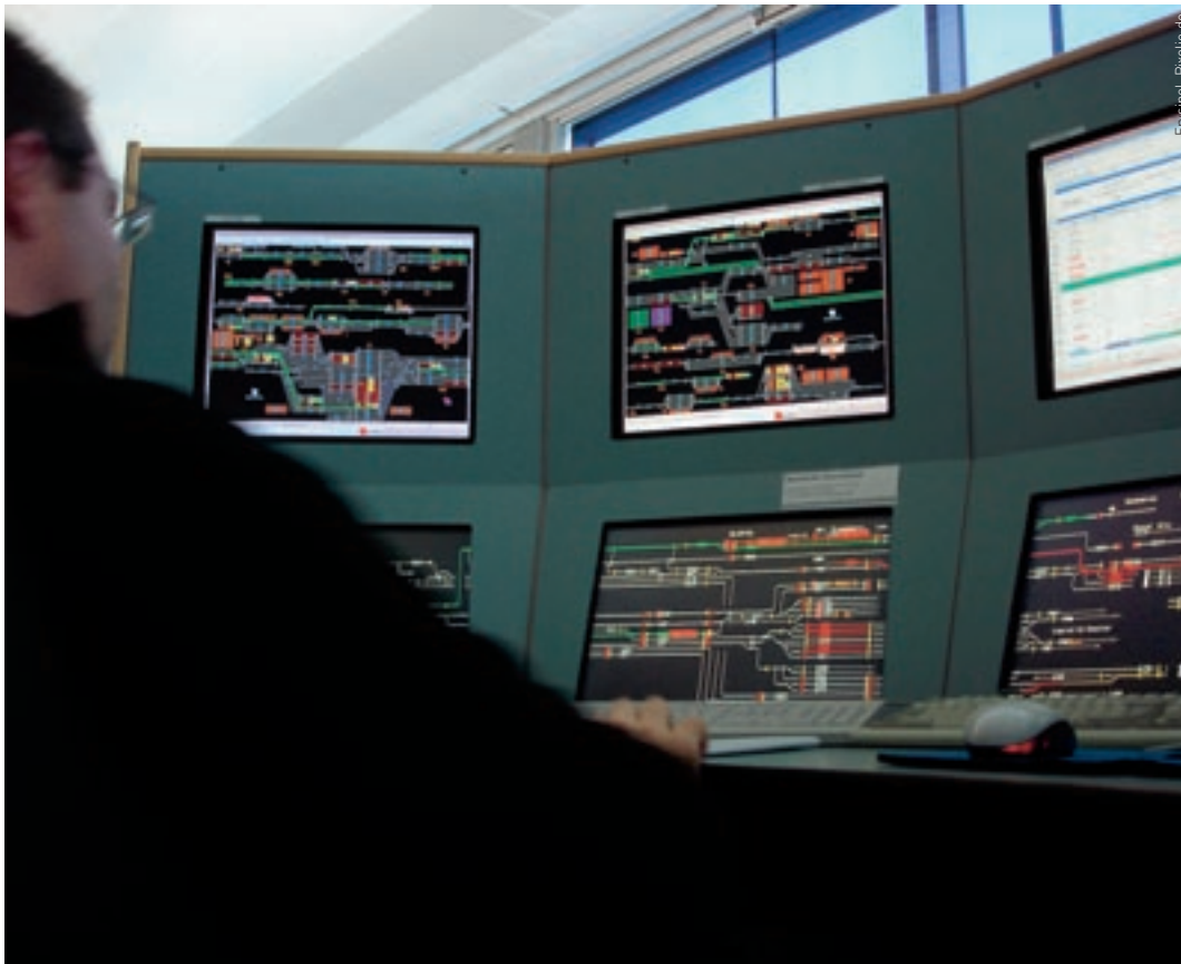
Wenn die Computer in der Leitstelle abstürzen, stehen die Züge auf den Schienen still.
